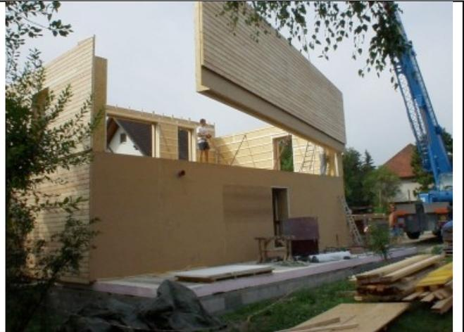
*Assemblage d'un bâtiment passif préfabriqué en atelier
