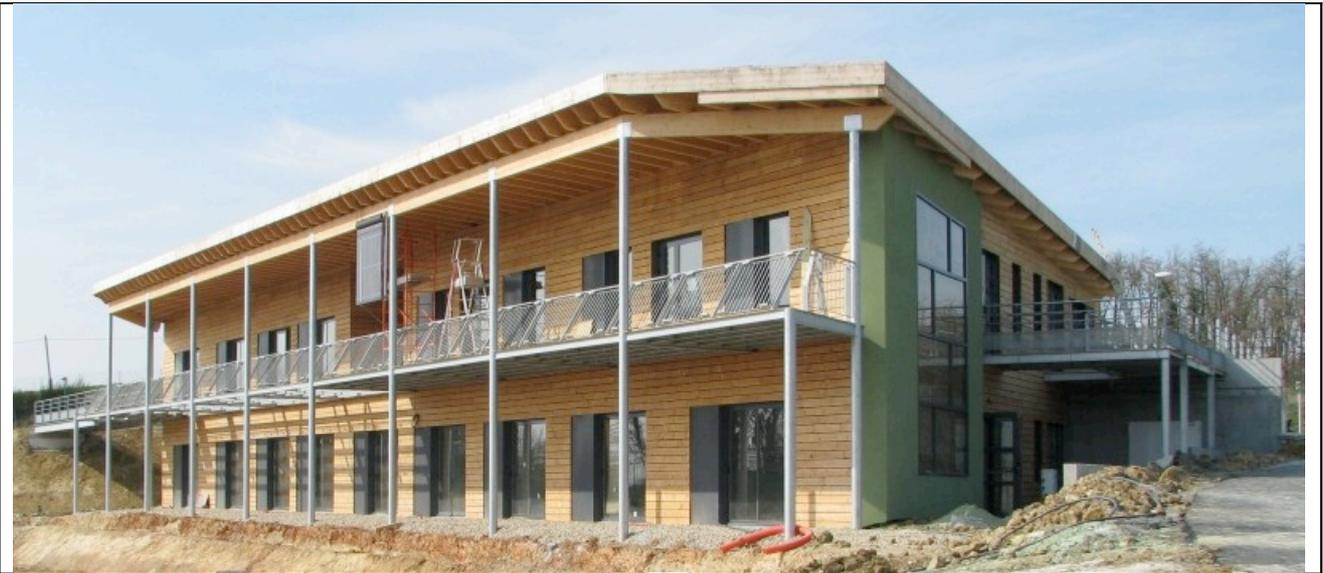
Bâtiment tertiaire: structure béton, isolation par l'extérieur en laine minérale, laine de chanvre, paille. Parements enduits et en bardages bois. Architecte Max Faramond (Albi - 81).
